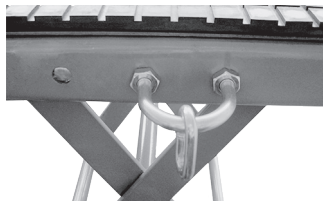
Рисунок 3 - Установка болта-скобы
